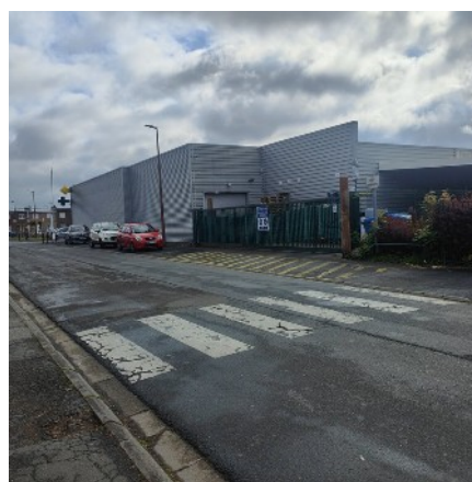
Photo 15 : demande de déplacement passage piéton pour sécurisation (non approuvée par la mairie)
