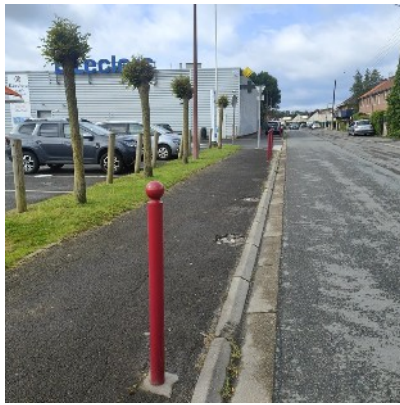
Photo 11 : signalement de deux poteaux manquants, rue de la résistance
