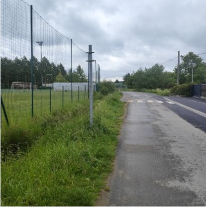
Photo 1 : panneau manquant, rue Charles Flon communale
