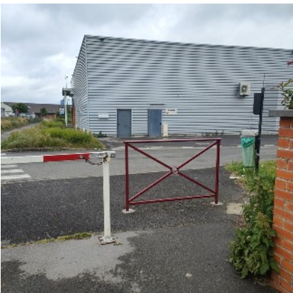
Photo 7 : barrière empêchant le passage PMR, rue des rosiers
