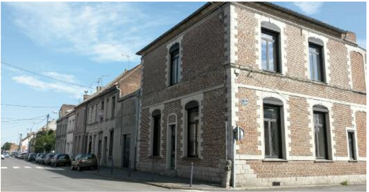
Rue Léon Rudent, ce qu'il reste de l'ancien béguinage et du couvent
